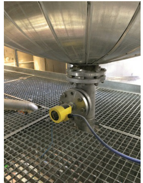
在一个蒸馏锅炉中用于进行电子式压差测量的主传感器
