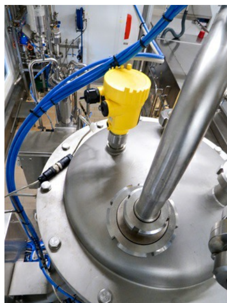
用VEGA传感器来控制液位，以确保酸奶的罐装能够顺利进行。
